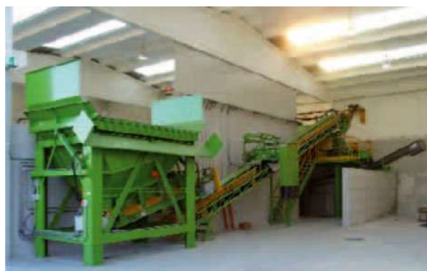
Tramoggia di carico e nastro alimentatore
